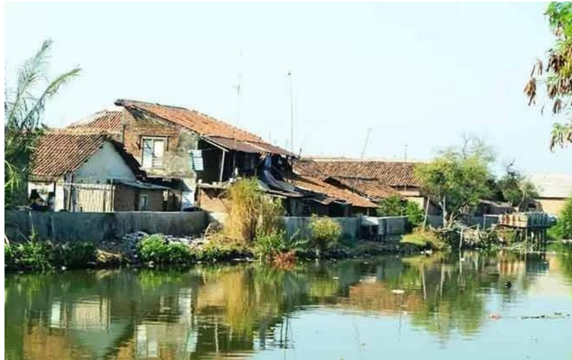
Gambar 4.5 Kondisi Rumah di Kota Cirebon yang rawan terhadap Angin Kencang
